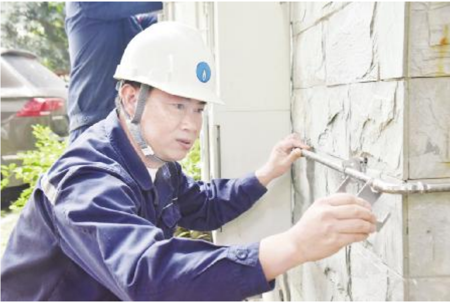
“360 先锋”党员刘明在瓶改管现场进行安装作业。
