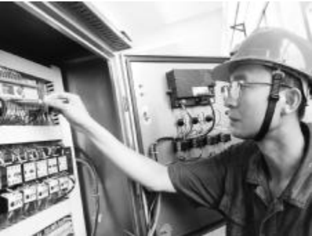
●徐磊正在检修自动加药机控制柜。
