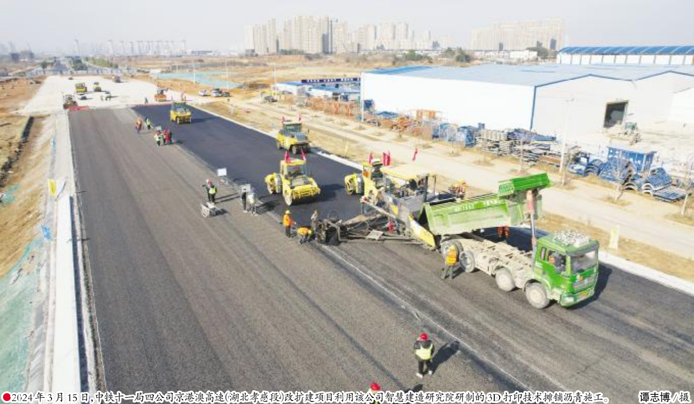
●2024 年 3 月 15 日,中铁十一局四公司京港澳高速(湖北孝感段)改扩建项目利用该公司智慧建造研究院研制的 3D 打印技术摊铺沥青施工。 谭志博/摄
