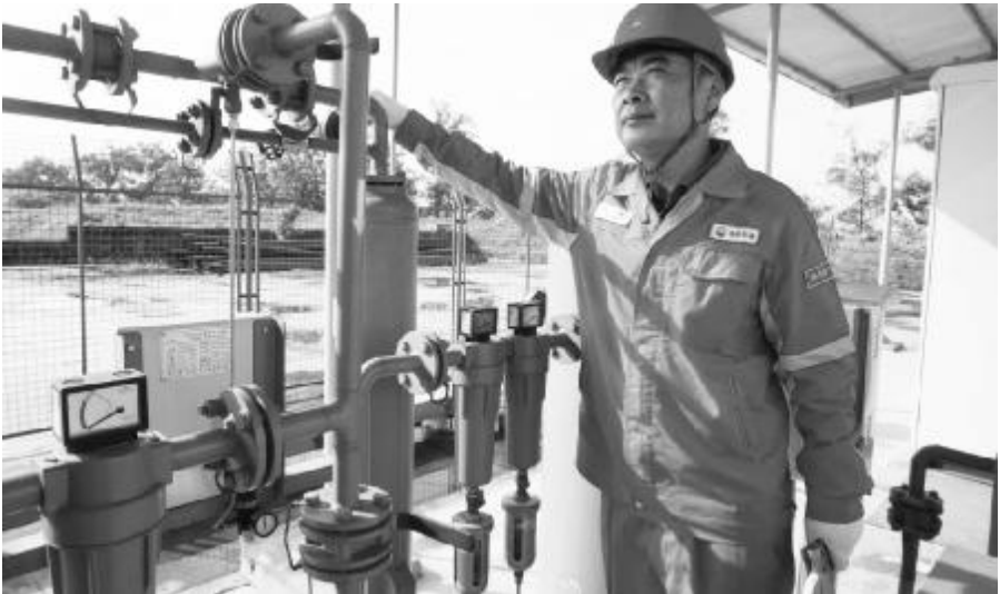
● 图为刘辉在黄202-H5平台调试起消泡剂加注装置
