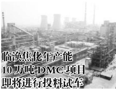
日前，安徽淮北矿业集团临涣焦化公司年产能10万吨DMC项目进入联机试车和试生产阶段，计划7月底进行投料试车，预计8月中旬出产品。该项目总投资额近10亿元，装置规模为10万吨/年碳酸二甲酯、1万吨吨级碳酸二甲酯，采用气相一氧化碳甲醇羰基化法生产碳酸二甲酯。图为7月13日该公司年产能10万吨DMC生产装置一角。魏玉东 摄影报道
