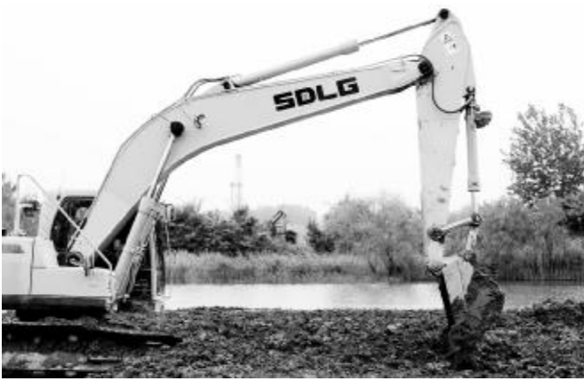
●恒源煤矿王引河(刘桥段)堤防隐患整改工程紧张施工中。
