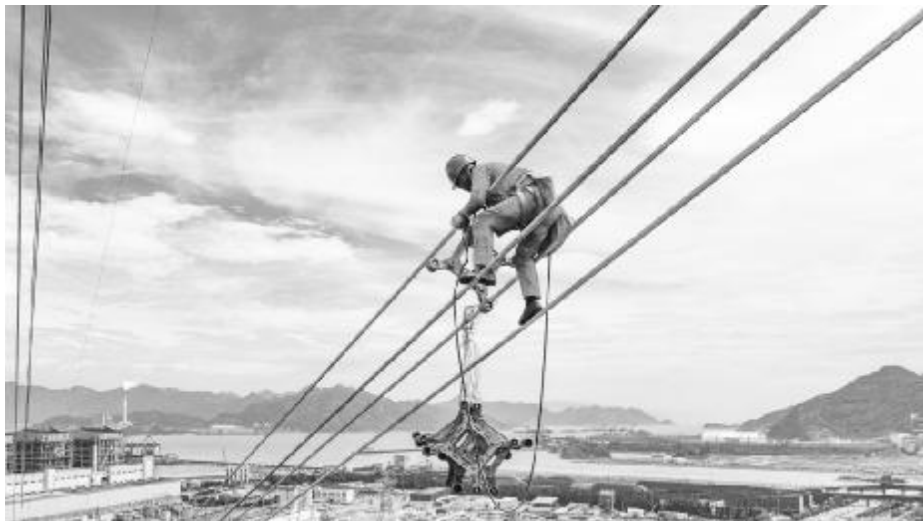
● 6月21日,国家电网福建送变电公司巡检人员在福建省连江县坑园镇可门电厂三期500千伏送出工程进行检查。(国网福建电力供图)
