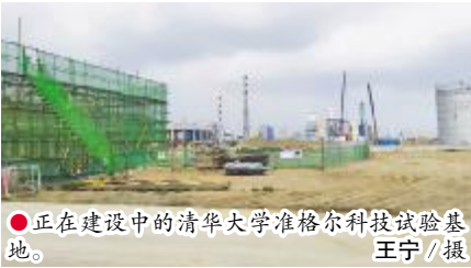
●正在建设中的清华大学准格尔科技试验基地。王宁/摄
