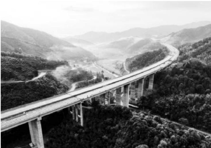
于平坦的河道两侧,其余除桥台外墩位均处于自然山体陡坡山腰上,直线高差达46m,外加上施工便道纵坡极大,桩基平台开挖极易引发滑坡风险,桥址区吊装机械作业困难和材料运输难度大的问题。
