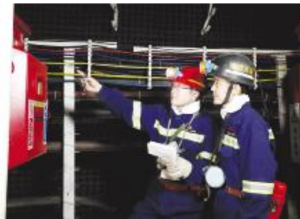
●师傅李东升为徒弟米永红讲述防爆移动变电站参数设置
