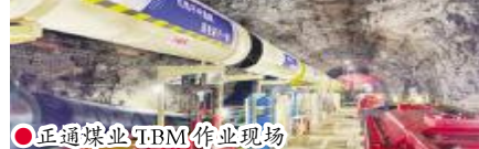
● 正通煤业 TBM 作业现场
