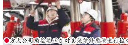
● 方大公司质检员正在对支架维修质量进行检查
