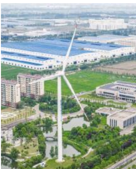
上大兆瓦风机——远景能源 EN-256/16.7 样机在盐城并网,这也是全球已并网的最大风机,中国海上风电再一次站在全球技术高地。“扫风直径 256 米,发电功率 16.7MW。”
