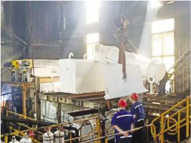
● 前锋精煤分公司改造精煤回收系统。
