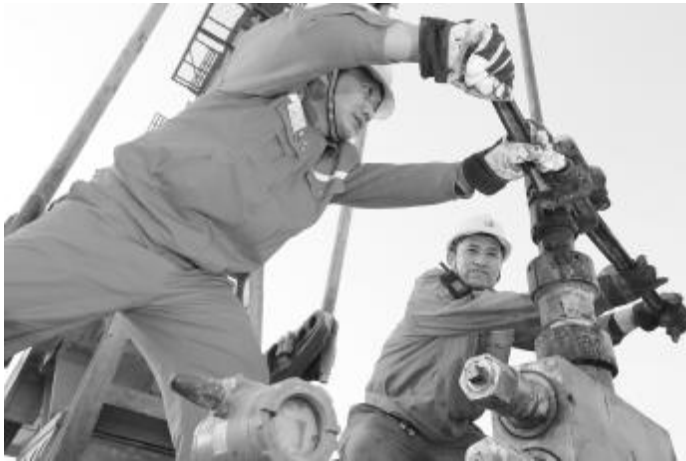
●塔河二部副经理梁红(左)和采油主任技师孙龙海在调整TH102107井防冲距后,紧固井口。
