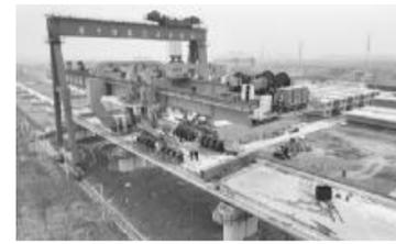
2月25日,在西延高铁富平制梁场,工人进行架桥机设备调试。
