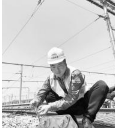
●4月9日，杨浩对接网改线小车进行升级改造。因他在调整改线小车轮子间隙。
