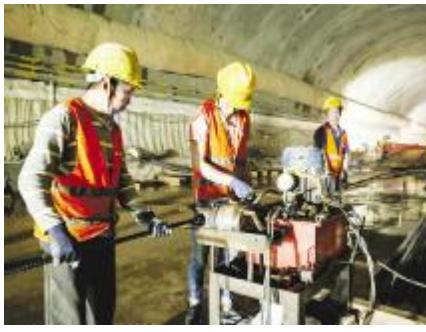
●2024年4月16日,在四川省华蓥市明月镇境内的西渝高铁草靶场隧道,建设者正在连接仰拱钢筋。
