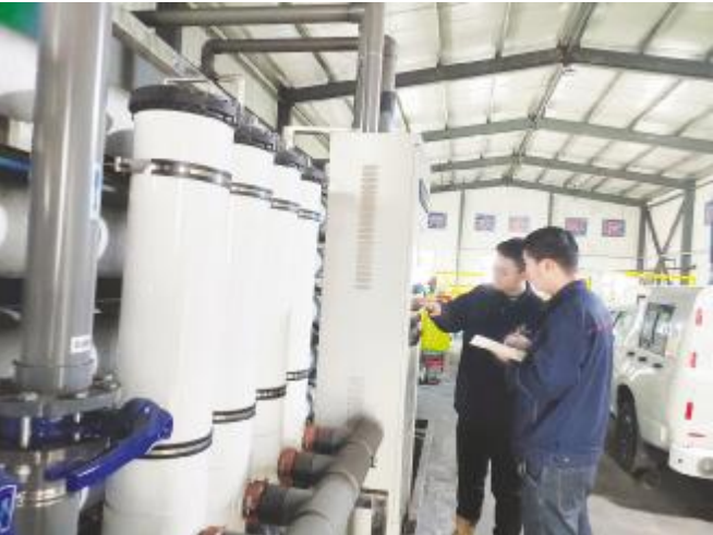
●技术员对矿井水净化装置参数进行校验。
