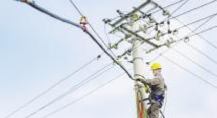
●绑扎固定架空电缆。
