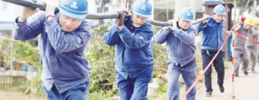
●在迁改现场展放电缆。
