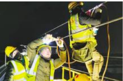
●2月23日凌晨,中铁建电气化局南方应急救援中心抢险人员在抢修线路上对沿线接触网检查抢修。(习斌 摄)
