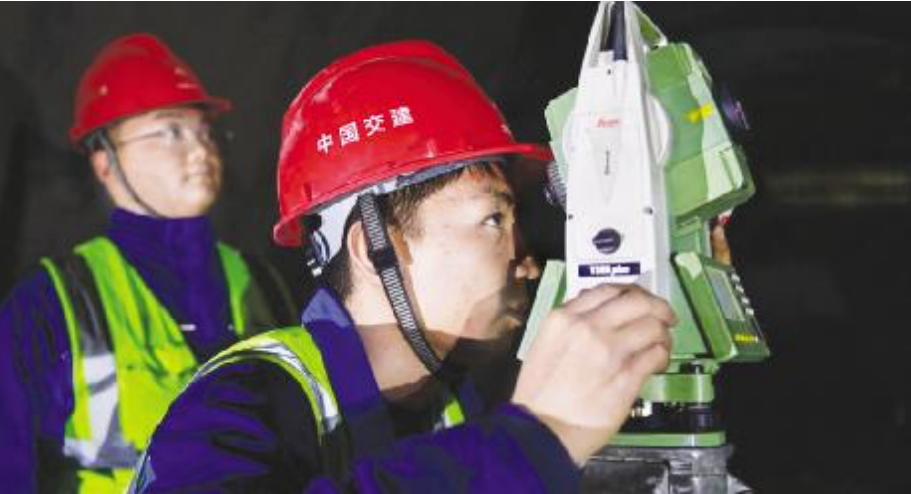
●在乌鲁木齐至尉犁高速公路6标段(隧道出口端),工作人员对钻孔位置进行测绘(2月23日摄)。
