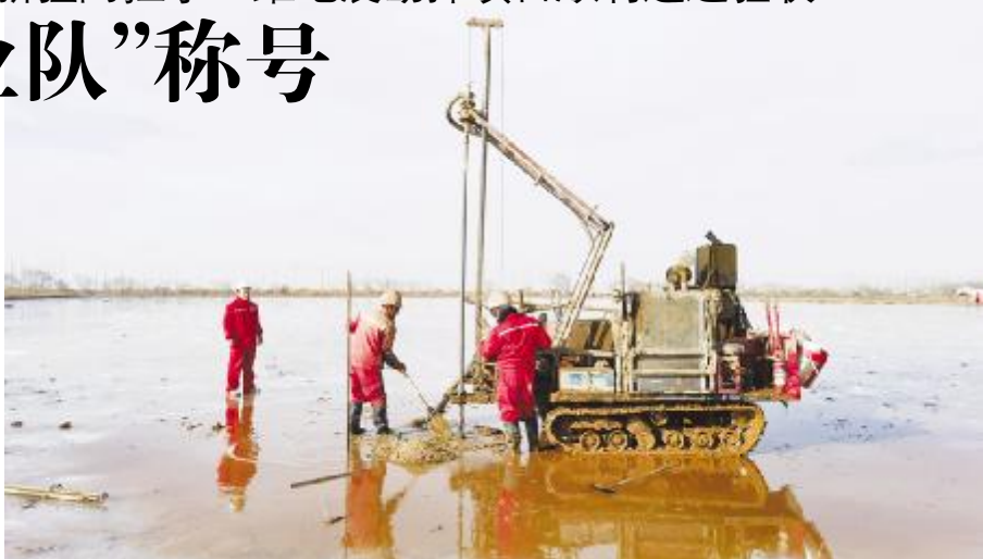
钻机班员工在封冻的水浇地上打井施工
