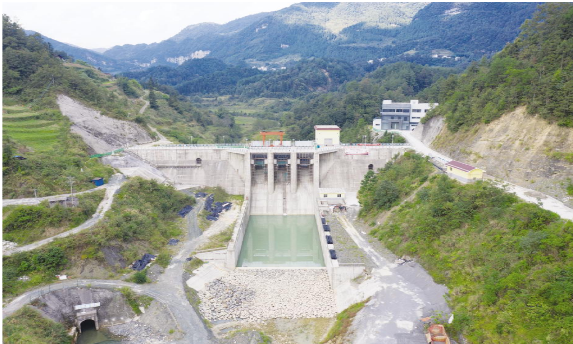
●龙虎水库大坝航拍图
