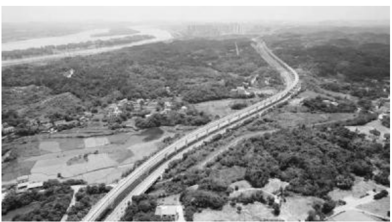
●2023 年 6 月 28 日，长株潭城际轨道交通西环线一期工程开通运营，这是湖南省首条跨城市轨道交通线路，开通后长沙和湘潭之间的通勤时间缩短至 20 分钟左右，极大方便了两市市民跨市出行。图为当日拍摄的长株潭城际轨道交通西环线“无接触网”高架轨道（无人版照片）。
