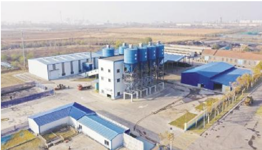
●梁家煤矿充填站全貌
