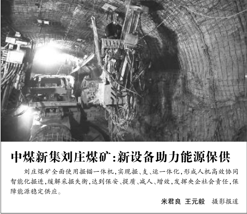
中煤新集刘庄煤矿:新设备助力能源保供
