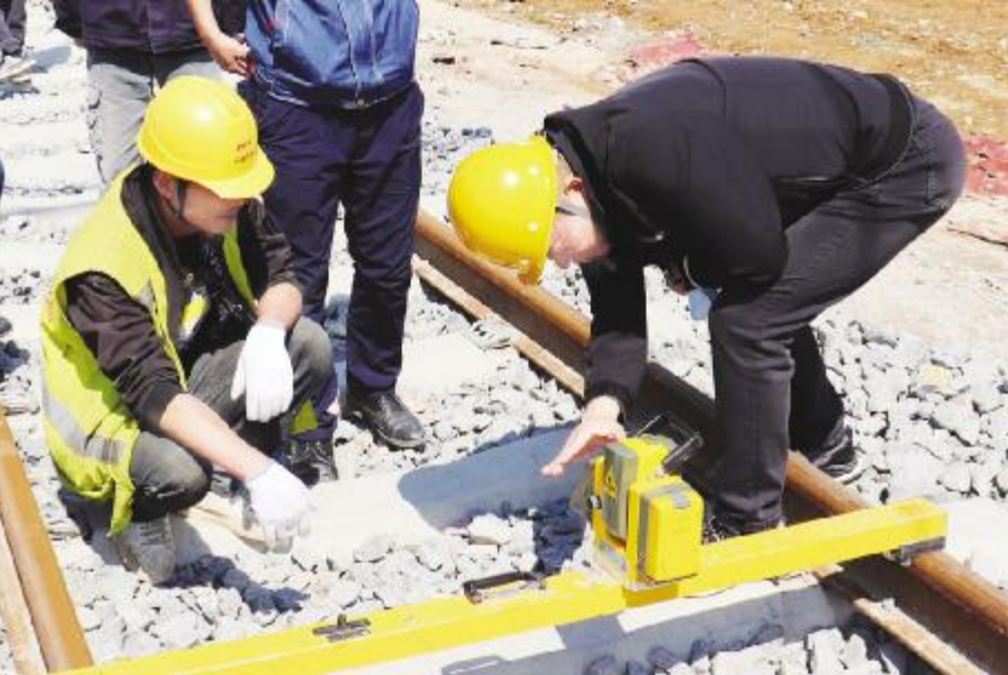
●2023 年 4 月 9 日,中国铁建电气化局集团北京城轨公司南京地铁七号线项目部员工在测量导高。(孙海涛摄)
