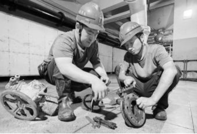
●博选公司维修人员整改组装电磁阀。
