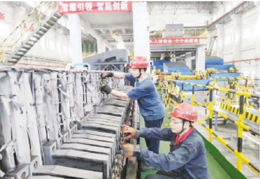
● 博选公司选煤事业部正在对压滤机进行检修。
