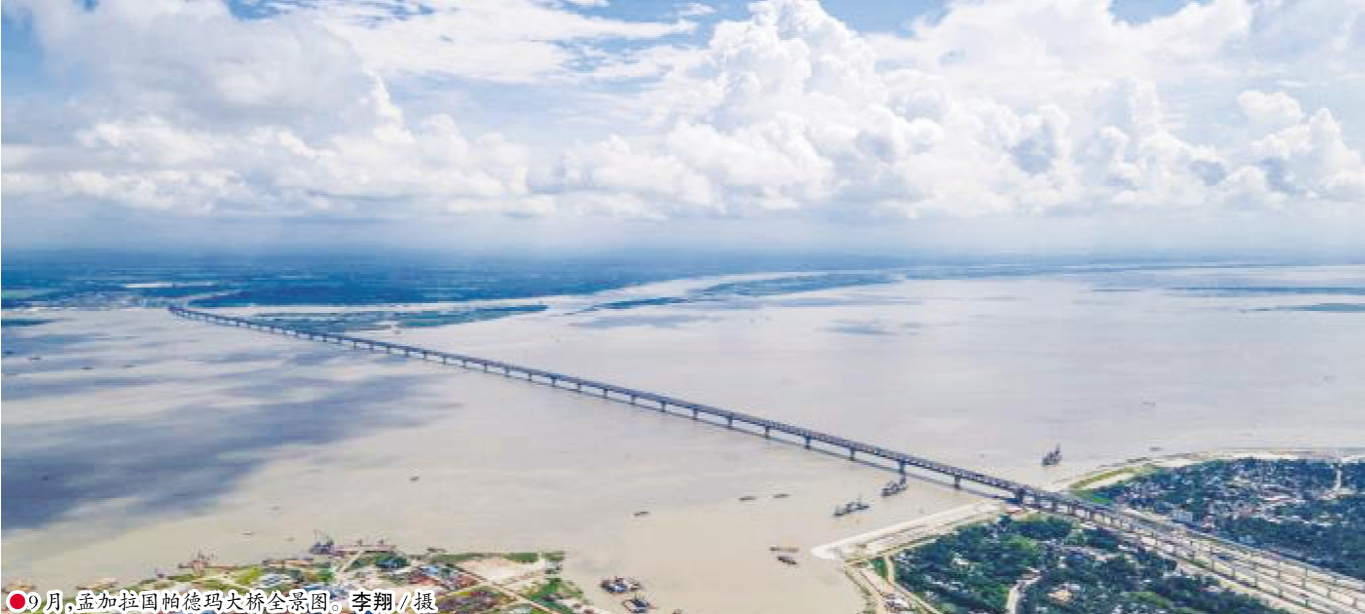
●9 月,孟加拉国帕德玛大桥全景图。李翔/摄
