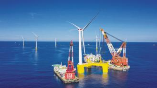
●全球首台抗台风型漂浮式海上风电机组
