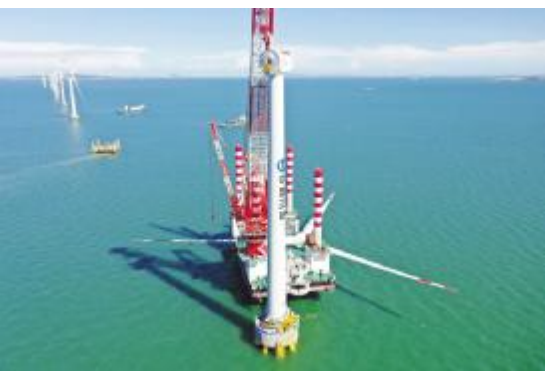
●福清兴化湾二期海上风电场吊装10兆瓦海上风电机组
