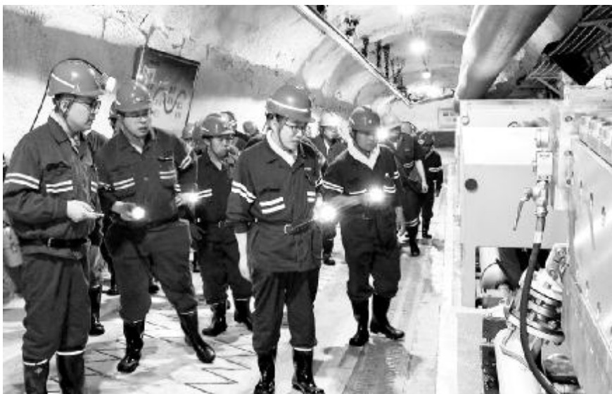
● 现场公开准证工作面系统安装
