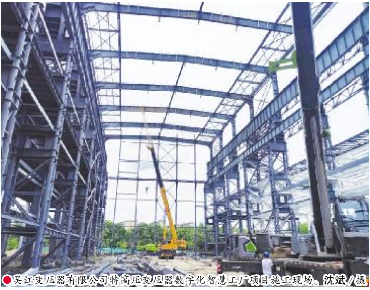
● 吴江变压器有限公司特高压变压器数字化智慧工厂项目施工现场。沈斌/摄。
