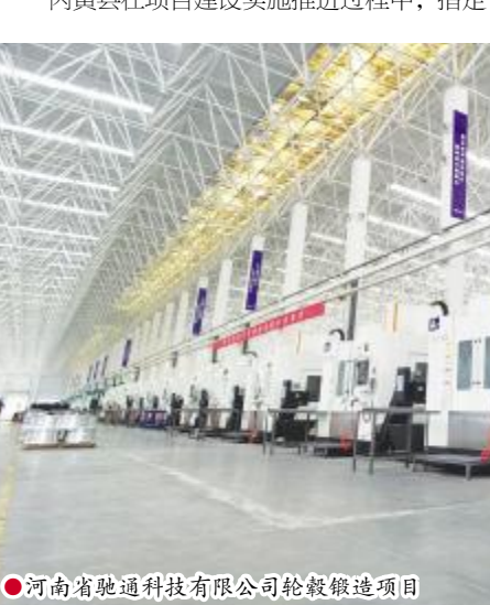
●河南省驰通科技有限公司轮毂锻造项目
