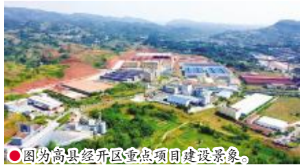
●图为高县经开区重点项目建设景象。
