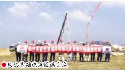
●风机基础浇筑圆满完成
