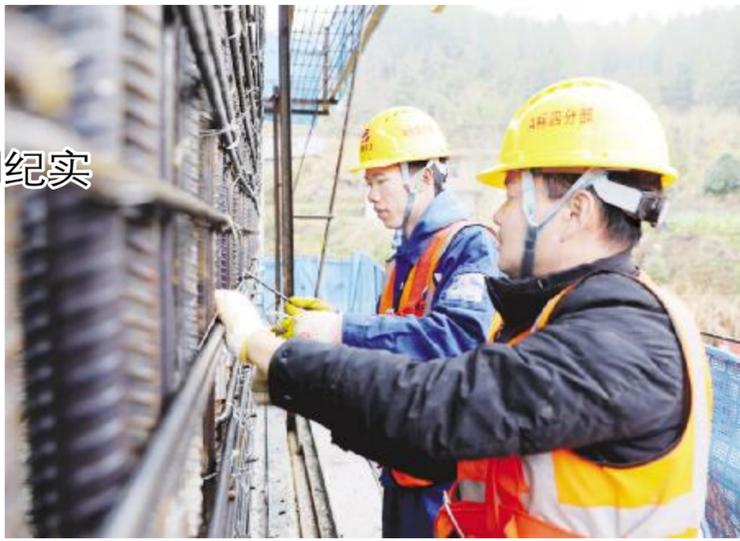
● 江西交工遂大高速 A 标路基四分部工人冒雨在扎桥梁钢筋。
