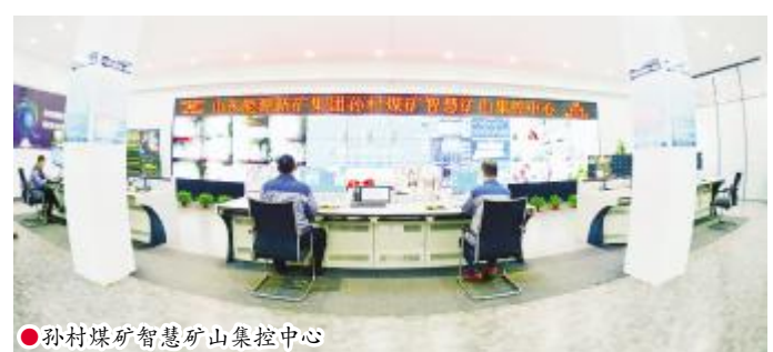
孙村煤矿智慧矿山集控中心
