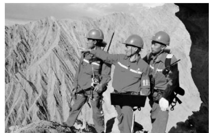
肖杰(中)在施工现场指挥
