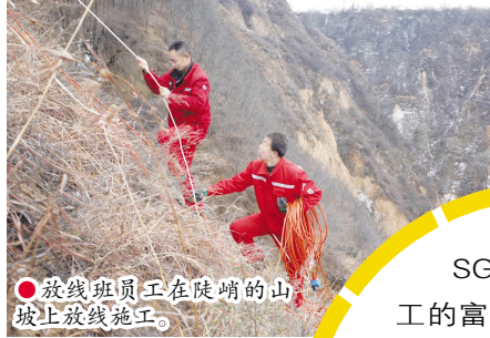
●放线班员工在陡峭的山坡上放线施工。
