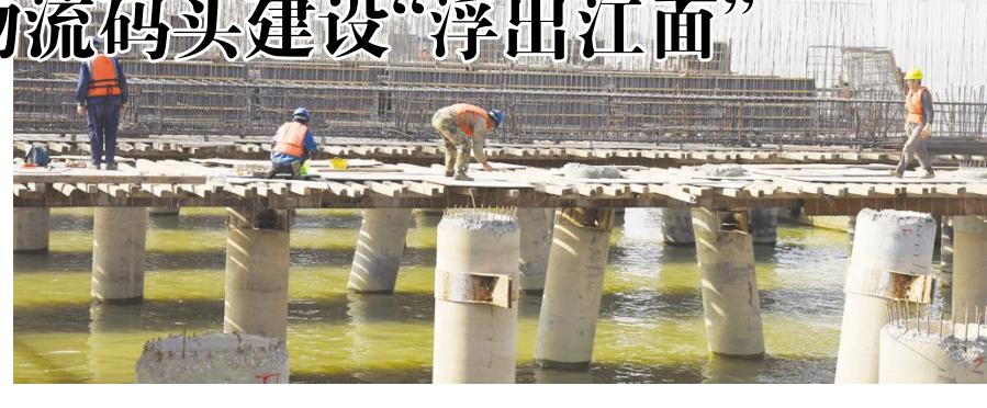
11月9日,中海工程建设总局有限公司员工在马鞍山港快捷物流码头进行水上平台下横梁施工。施工单位抢抓天气晴好时机,确保工程节点稳步推进。
