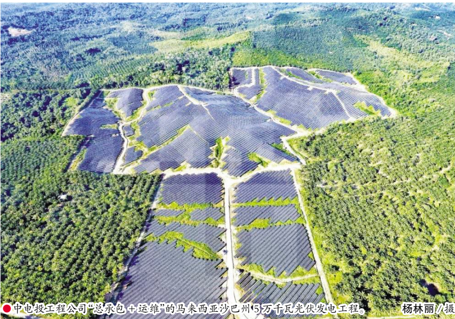
●中电投工程公司“总承包+运维”的马来西亚沙巴州5万千瓦光伏发电工程。 杨林丽/摄
