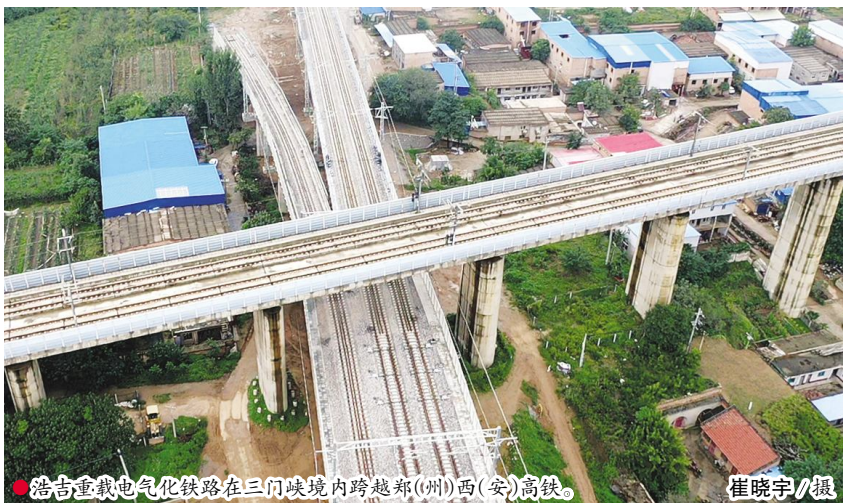
●浩吉重载电气化铁路在三门峡境内跨越越(州)西(安)高铁。崔晓宇/摄
