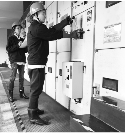
●二名工作人员正在进行配电倒闸操作
