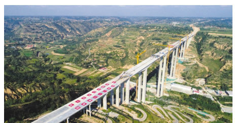
●中铁二十三局承建天宁沟特大桥
