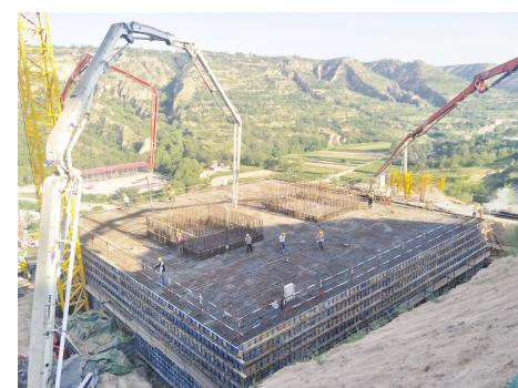
●浇筑承台混凝土
