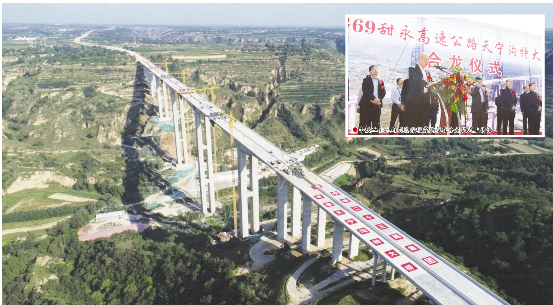
●天宁沟特大桥飞架南北
