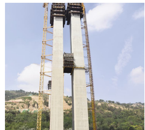
●墩梁异步法施工工体系
