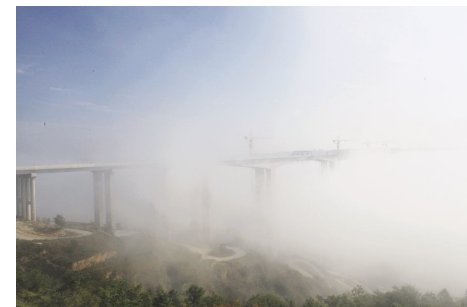
●清晨薄雾笼罩下的天宁沟特大桥若隐若现
