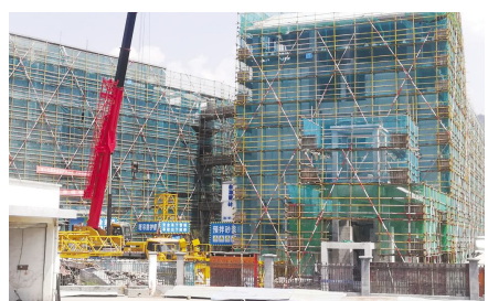
正在建设中的中药材初加工项目
