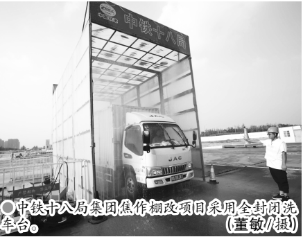
●中铁十八局集团焦作棚改项目采用全封闭式洗车台。(董敏/摄)
