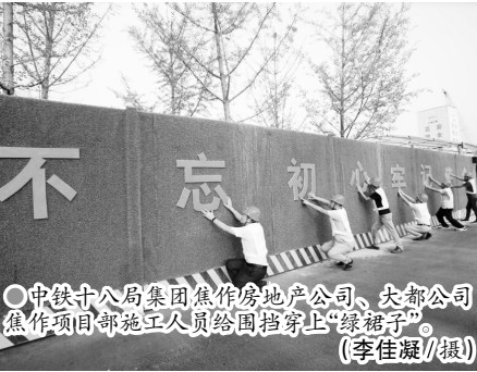
●中铁十八局集团焦作房地产公司、大都公司焦作项目部施工人员在给围挡穿上“绿褂子”。(李佳凝/摄)
