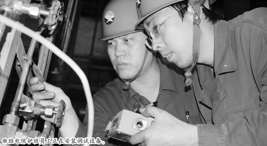
○继电保护班员工正在安装调试设备。
