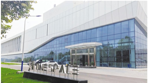
● 位于重庆两江新区龙兴工业园占地面积100亩的零壹空间火箭智能总装制造基地。
