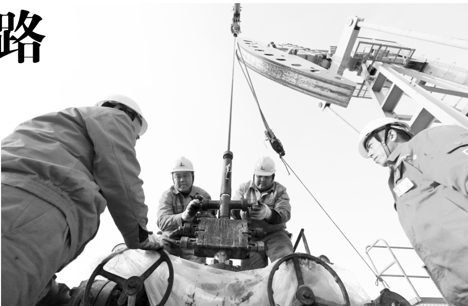
●带压更换光杆,提高生产效率。
