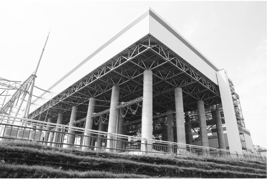
● 沙河电厂利用“空冷岛”年节水1500万吨
